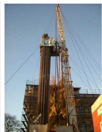
Geothermiebohrung für die Erdwärmesonde des SuperC-Gebäudes in Aachen
