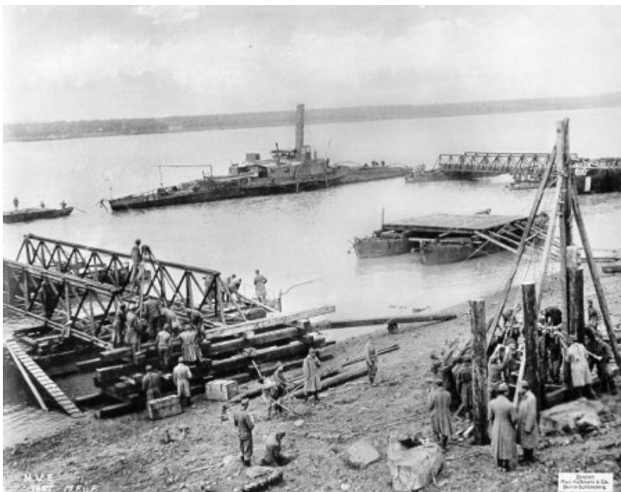
37. Készül a pontonhíd Svistovnál
