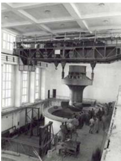
A turbina-forgórész behelyezése
