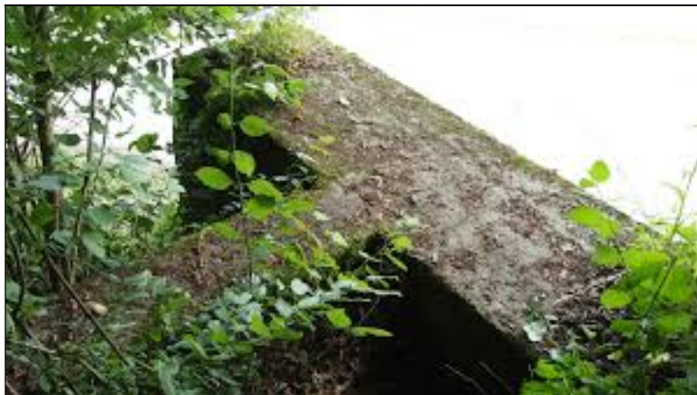
V Železníku ostali z lanovky len betónové základy. (Zdroj: www.chronica.sk )
