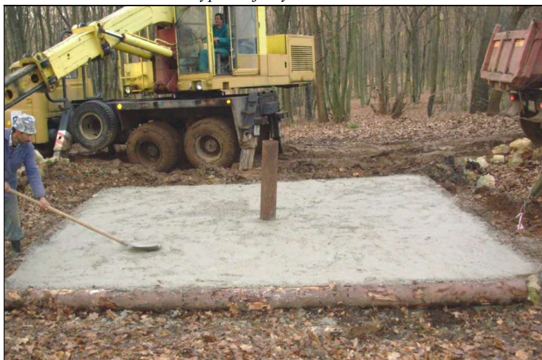
Zasypanie jamy základkou.
