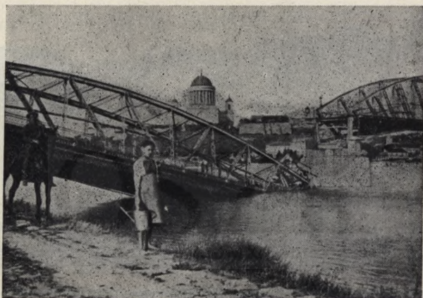
Esztergom. A Duna-híd felrobbantása a csehek által.
