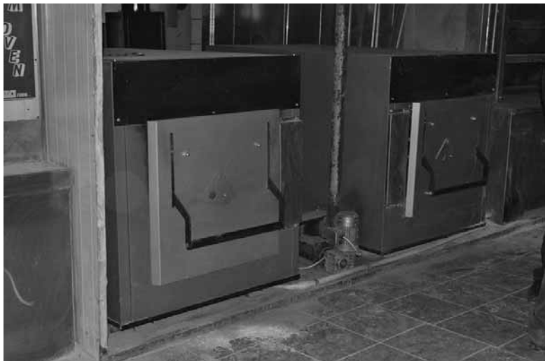
3. ábra, Biomassza kazánok a gelencei pékségben, forrás: saját felvétel, 2018
