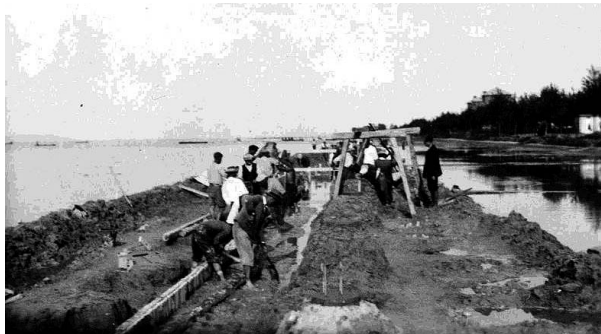
11. kép. A partvédőmű betonozása, 1936.
