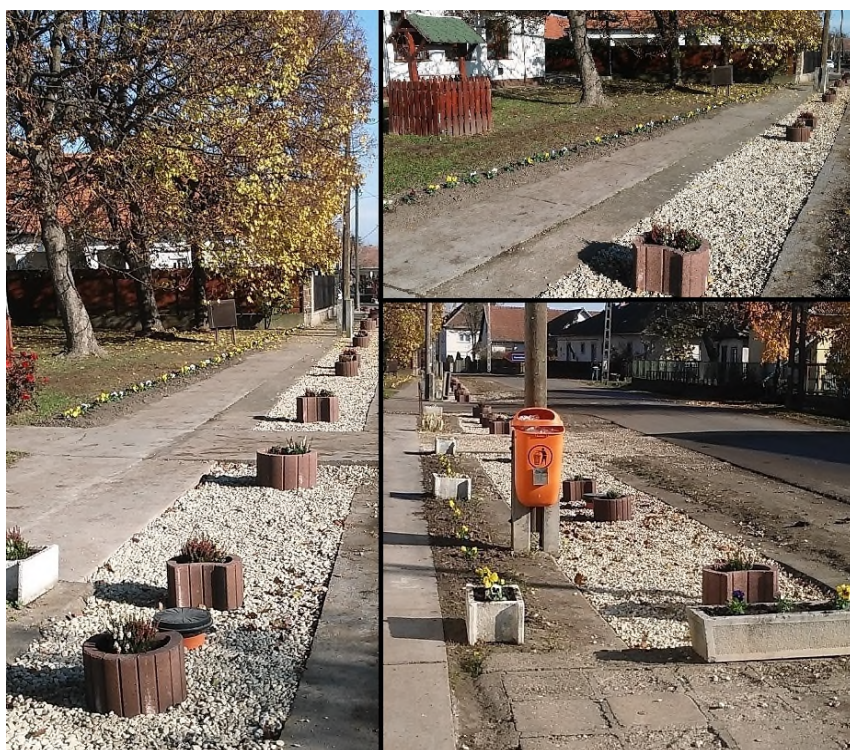
Árok-befedés, felszín alatti csapadékvíz elvezetés
