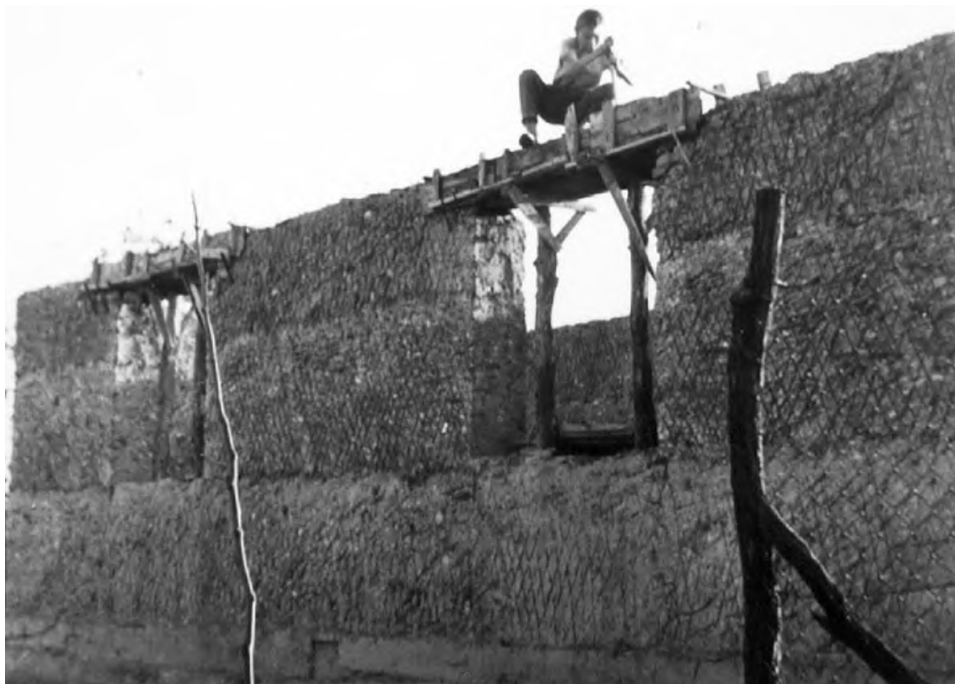
A rakott (fecske) fal három része jól látható
