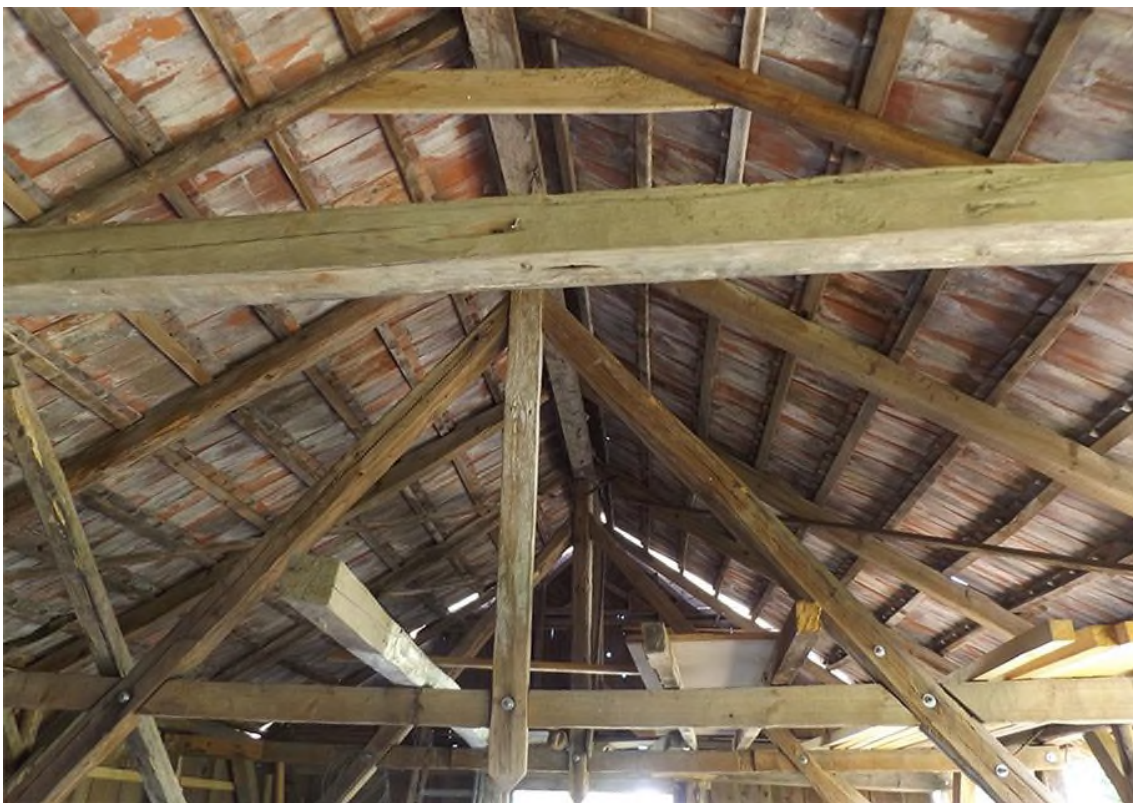
A pajta (csűr) tetőszervezete belülről (Bucsa)
