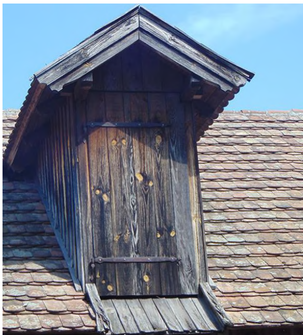
A hódfarkú cseréppel fedett padlástérbe nyíló tetőajtó. (Békés)
