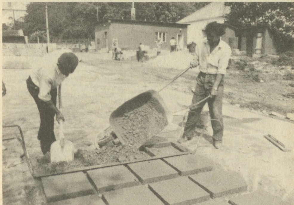
Bagamér (Bocskai u. 14.) betonüzem dolgozói munka közben
