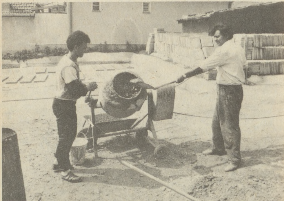
Bagamér (Bocskai u. 14.) betonüzem dolgozói munka közben
