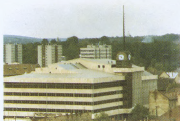
MISKOLCI TÁVBESZÉLŐ KÖZPONT (ÉPÍTÉSSZERELÉS 390 M Ft)
