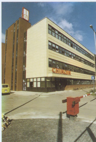
ÉPÍTÉSZETI NIVÓDÍJVAL KITÜNTETETT CHINOIN INJEKCIÓS ÜZEM (530 M Ft)
