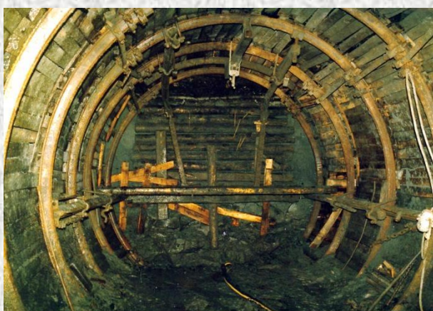
4 méter átmérőjű, acéllal biztosított vágat
