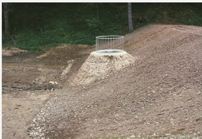
A Tacsi-árok közzóléti tavát védő hordalékfogó kistó még feltöltetlen állapotban (©RJ)
