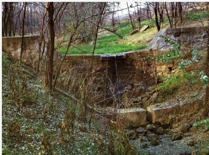
Vízmosáskötő kőgát vízládás utófenékkal (©RJ)
