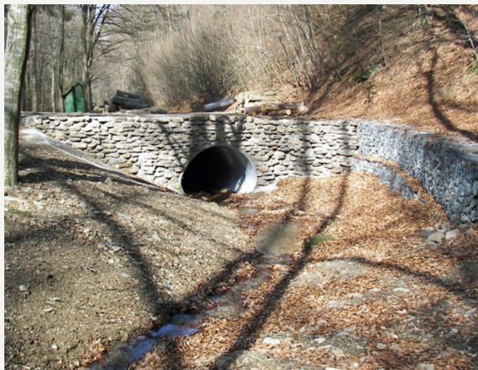
A Kőszegi-hegység Hámori útján újjáépített áteresztő (©PJ)
