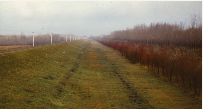
Az árvízvédelmi töltés védelmét szolgáló hullámtéri véderdő a szabadon tartandó sávval (©RJ)
