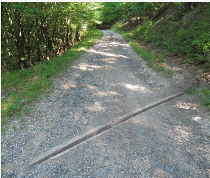
Keréknyomokban folyó vizet kivezető vízterelő (©KB)
