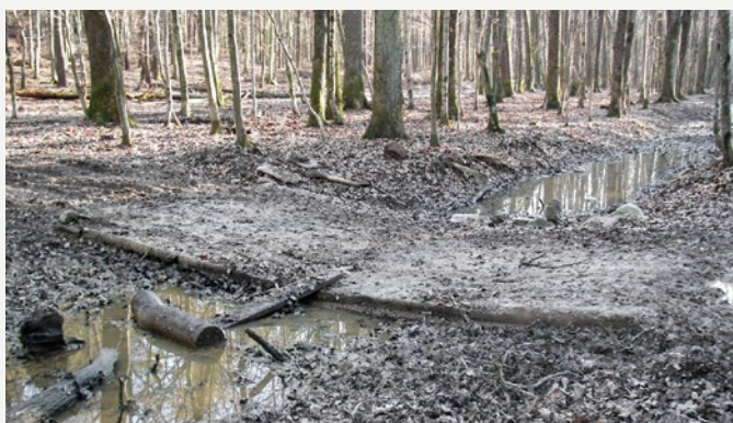
Az időszakos vízfolyás fenékszintjéhez képest kissé kiemelt mederátjáró (©KuM)
