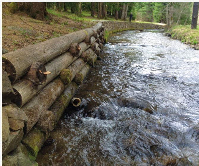
Part stabilizálása faanyagú művel (©KáM)
