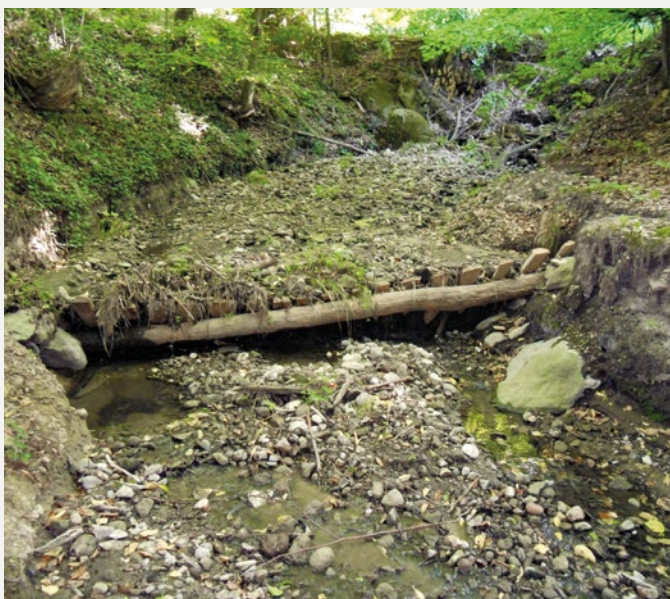
A fésűs hordalékfogó mögötti feltöltődéssel mederlépcső keletkezett, s a széles és kis esésű mederszakaszon csökken az időnként összegyülekező nagyvizek sebessége (©KB)
