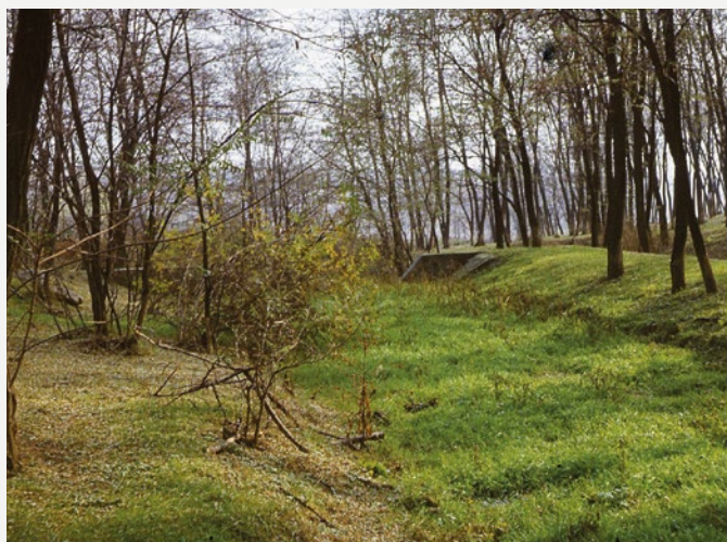
Vízmosáskötő kőgát feltöltődött, széles, kis hosszesésű, s a vegetáció által is „birtokba vett” gátudvara (©RJ)
