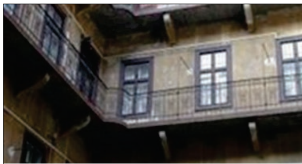
10A-1 Kép. Körfolyosós épület
