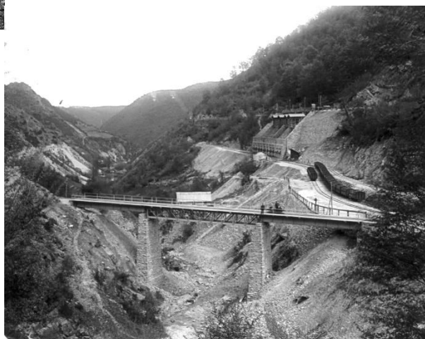
Gyalár melletti Retyisóra-völgy, az erdélyi bányavasút völgy áthidalása és ércrakodója. A legfelső szinten a villamos bányavasút pályája 369
