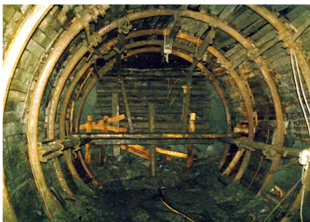
4 méter átmérőjű, acéllal biztosított vágat
