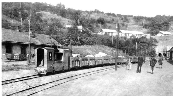
A gyalári főbánya Lukács László- tárójának szintje. AEG 365 villamos bányamozdony, 1910. Háttérben a Retyisóra völgybe vezető alagútak 366
