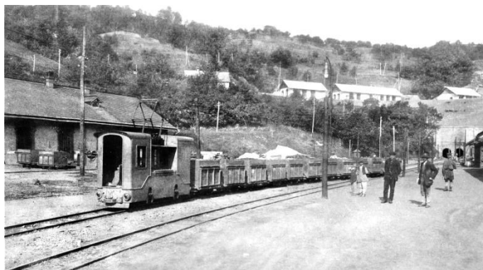
A gyalári főbánya Lukács László tárószint, AEG 72 villamos bányamozdony, vízszintesen szerelt munkavezetékek, hátul a Retyisóra völgybe vezető alagutak 73
