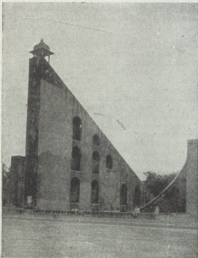
57. kép. A Dakhshina Bhitti Yantra, a nagy meridián fal a maharadzsza obszervatóriumában Jaipurban. A jobb oldalon lévő, 15 m sugarú, beosztott köríven a nap árnyéka szemmel láthatóan tolódik el.
