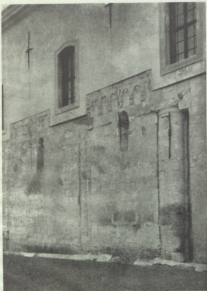
26. Feldebrő. A róm. kat. templom északi oldala mutatja a vakolatleverés nagyszerű eredményeit. A barokkori vakolat alól előtűntek a XI. és XII. századi formák.
