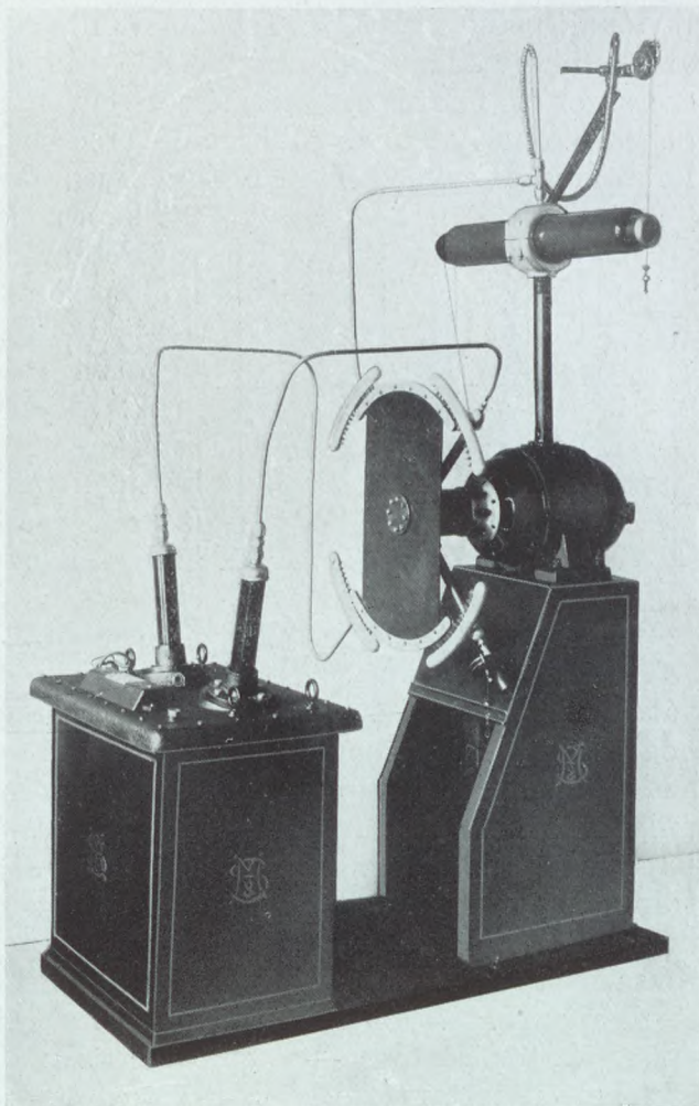
78b. kép. A Fővárosi Pedagógiai Szeminárium forgóegyenirányítós Röntgen-készüléke.
