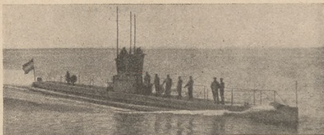
63. kép. „Atropo” olasz tengeralattjárónaszád (1912). 230—320 tonnás. 14·3—8 tmf/d sebességű.
