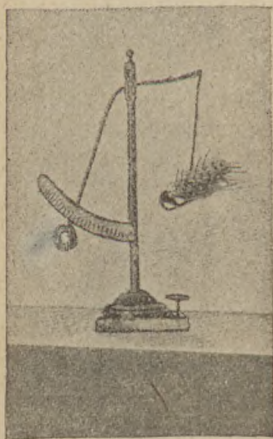
17. ábra. Levélmérleg kalászsúly mérésére.
