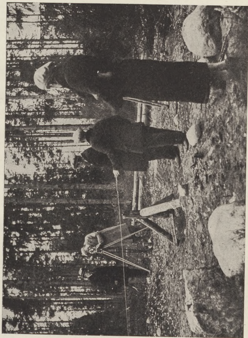
18. ábra. A drótok komparálása a nummelai próbaalapvonalon (fénykép)
